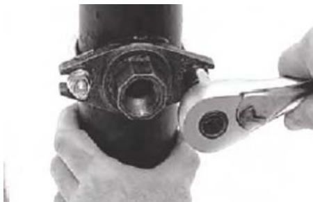
5. Dokręcanie śrub
