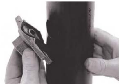
3. Instalacja uszczelki
