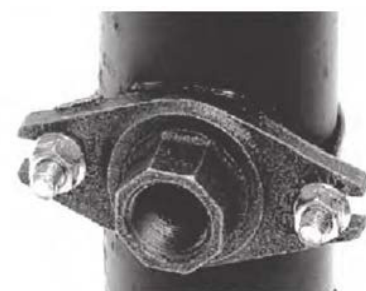
6. Zamontowany łącznik odejściowy
