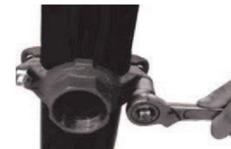
5. Dokręcanie śrub
