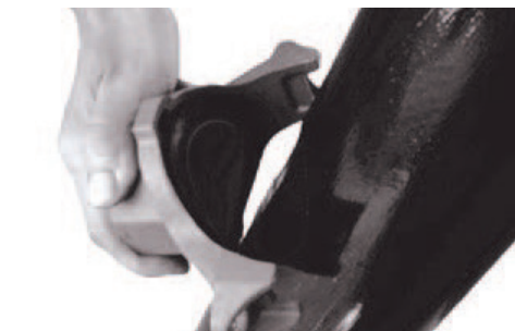
3. Instalacja uszczelki
