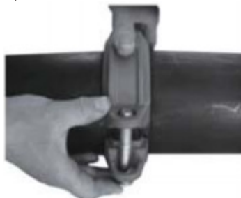
5. Montaż obudowy
