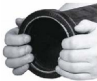
3. Mocowanie uszczelki
