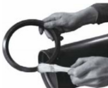
2. Smarowanie uszczelki
