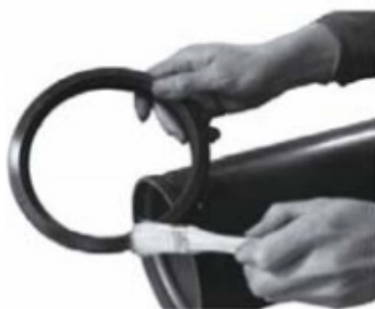
2. Smarowanie uszczelki
