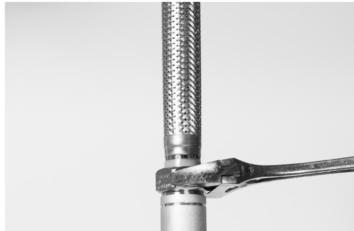
4. Savijte gibljivo crevo da biste postigli željeni pravac, održavajući minimalni radijus savijanja i postavite reduktor za lokaciju sprinklera. Kada savijate crevo, ostavite 65 mm pravog creva od navrtke, uverite se da nije savijeno i koristite Rapidrop indikator minimalnog poluprečnika, ako to zahtevaju nadležni organi.
