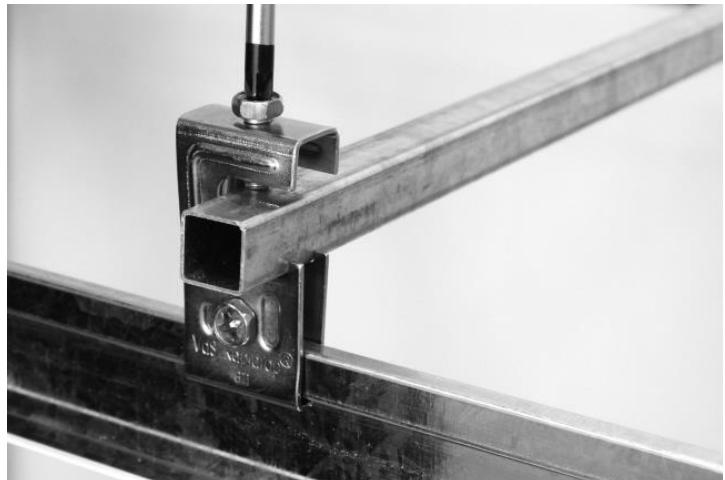
5. Zakačite bočne nosače tip B na glavne vođice spuštene tavanice, koristeći isporučene vijke. Lagano pritegnite bočne vijke da bi se nosači držali za rešetkaste šine tavanice.
