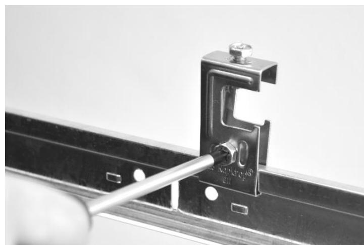
7. Gurnite srednji nosač tip A na poprečnu šipku, montirajte odvodni reduktor kroz srednji nosač tip A i lagano pritegnite navrtku. Podesite položaj srednjeg nosača i bočnih nosača tip B dok ne postignete željeni položaj odvodnog reduktora. Dobro pričvrstite bočne nosače tip B pritezanjem vijaka obrtnim momentom od 5 Nm / 4 ft-lbs.
