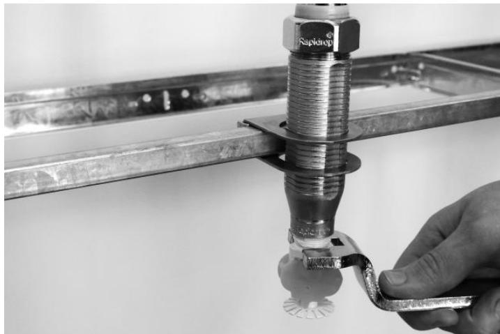
Kada se ugrađuje glava sprinklera sa dvodelnom rozetom, unutrašnji komad mora da se montira na navoj glave sprinklera pre nego što se natakne na reduktor.
