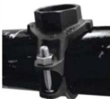
Rys. 7 Łącznik zamontowany na rurze
